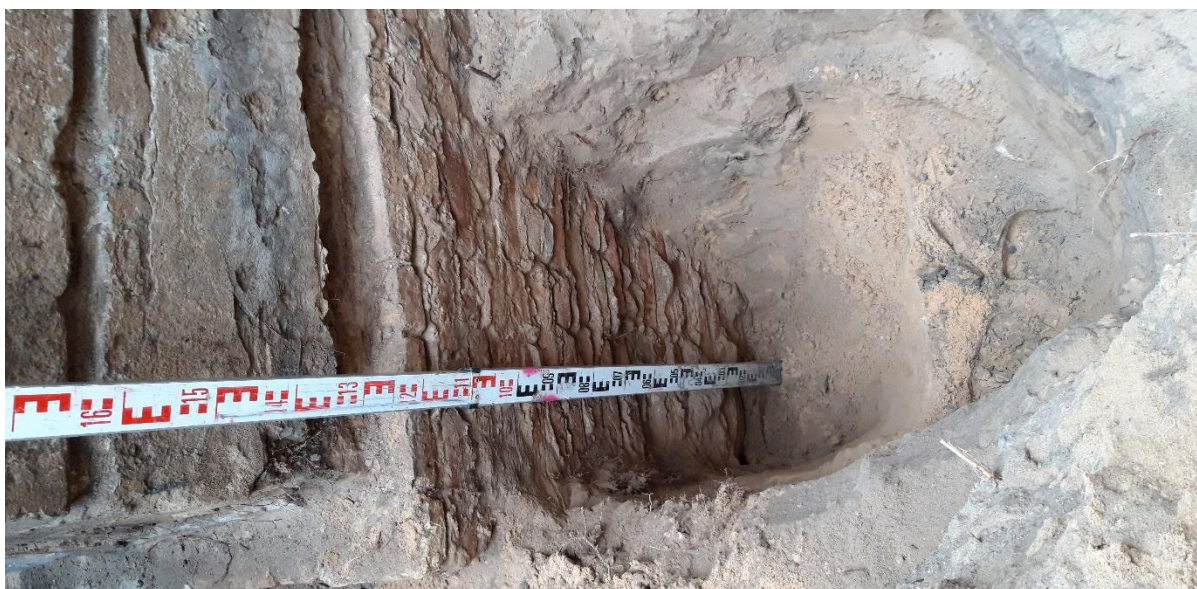
F.22. Šv. Roko koplyčios ŠR sienos išorinės dalies pamato vaizdas.
